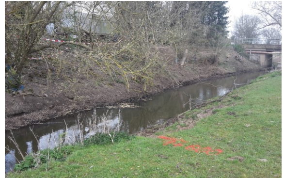
Foto 2: künftiger Standort für den Sedimentfang
